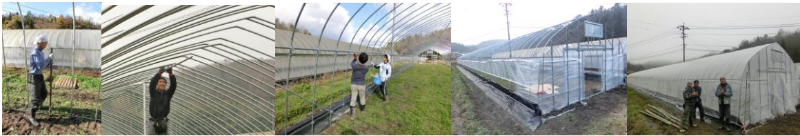
11/7 穴あけ 11/21 背直管取付 12/19 肩取付 1/23 側ビニル取付 1/31 天井ビニル取付
